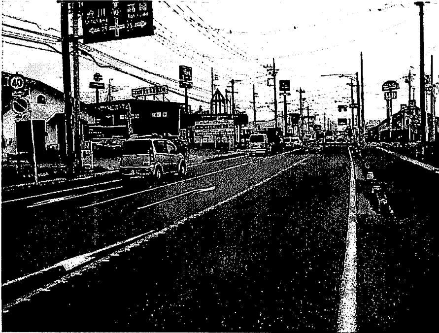
写真 22-4 写真中央が接触現場
