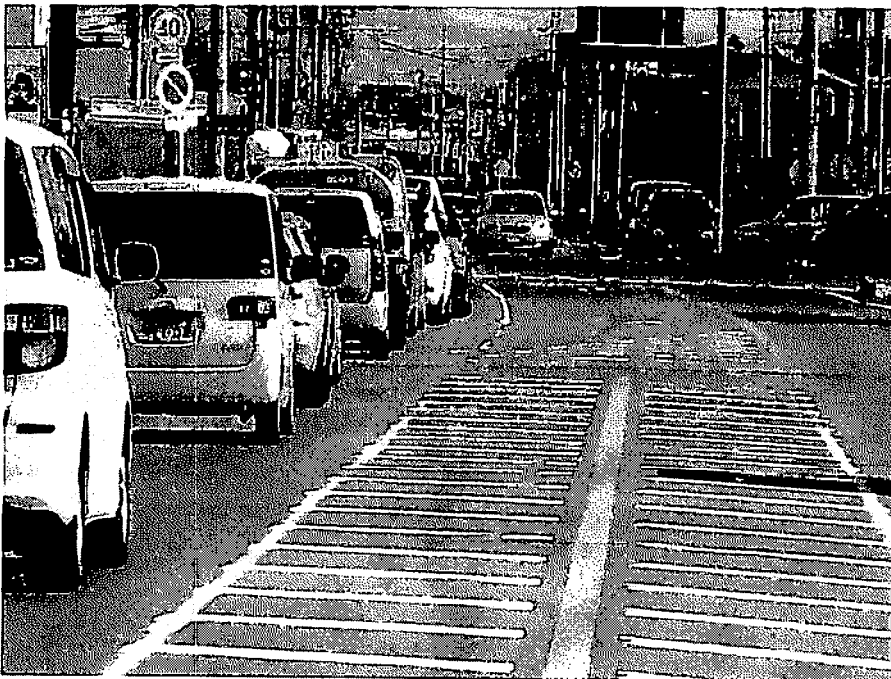
写真 22-5 混雑時車両停止状況 (写真中央に小交差点がある) 前方直進 赤信号で並列走行は出来ない道路構造である。 (ゼブラ部幅は車幅の半分、道路に 2 台並列走行する幅員が無い。)
