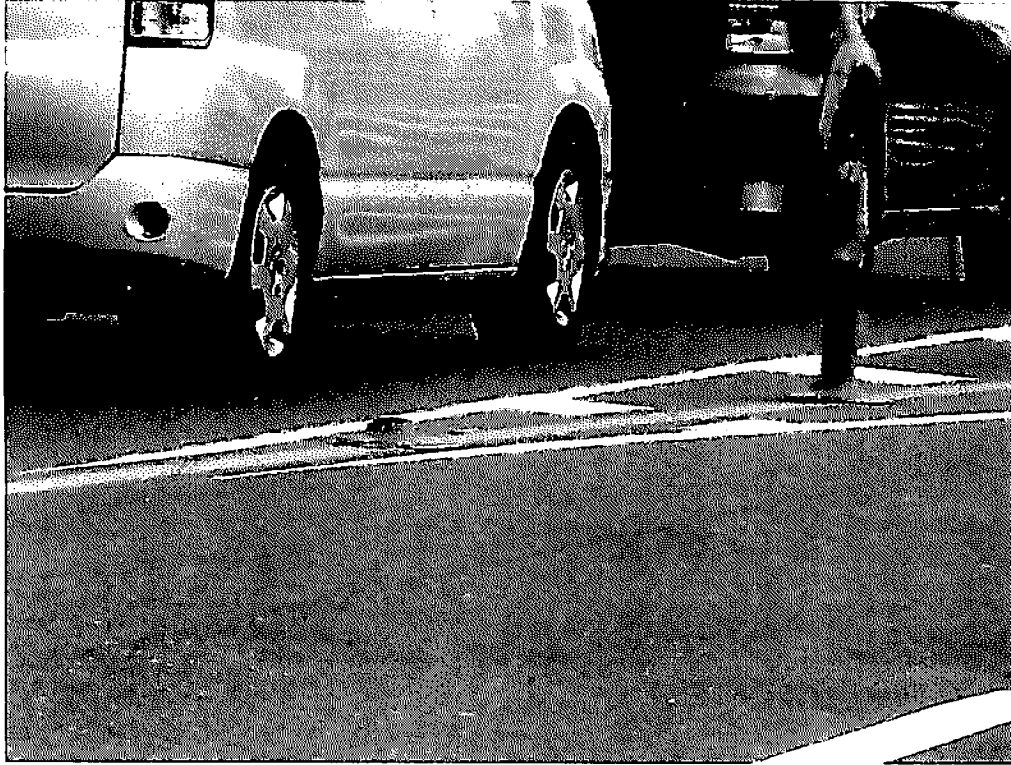
写真 22-6 路上設置の前橋方面行 1 車線規制分離ポスト 右折車線分岐部迄の並列走行をブロックしている。
